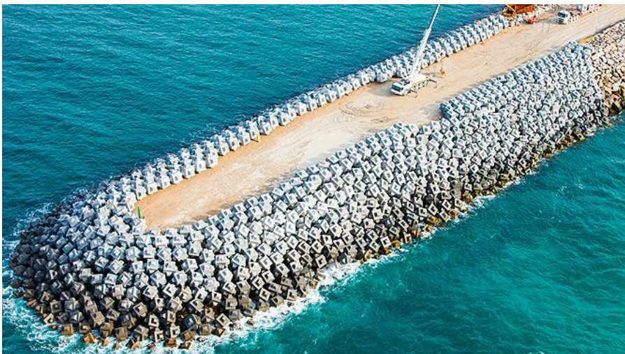
Figur 4 - Mole med dæksten af cubipods (lånt fra hjemmesiden cubipods)
